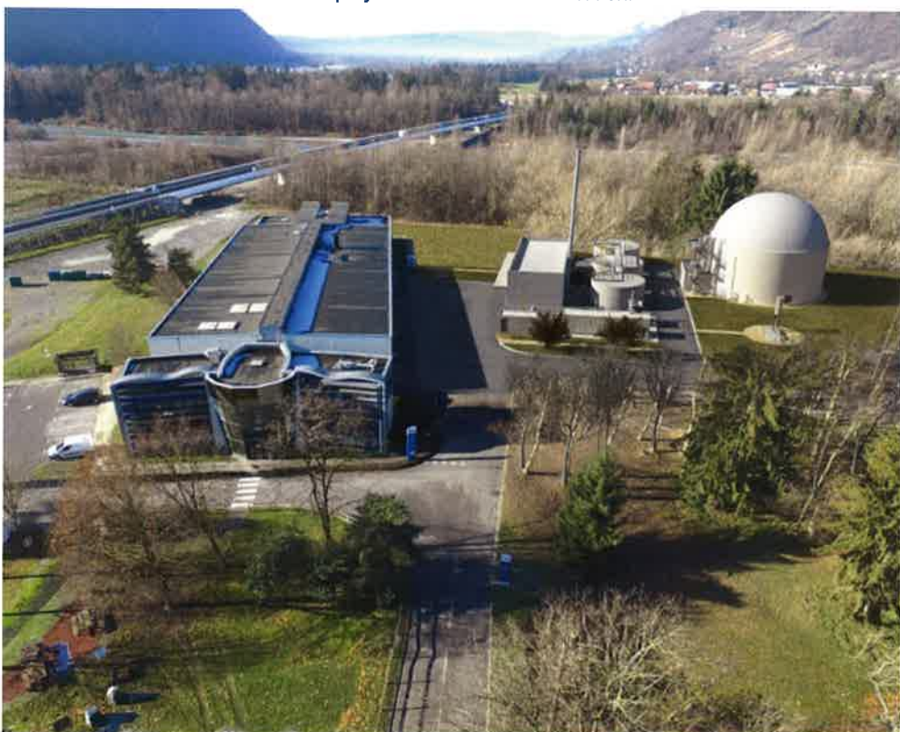
Usine de traitement des eaux usées et projet de l'unité de méthanisation.
